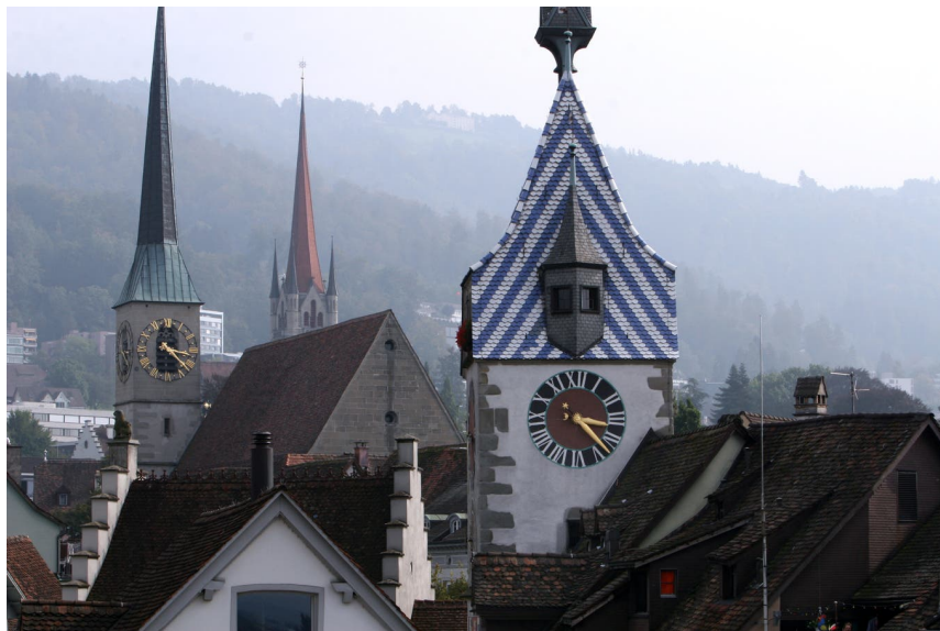
Bereits unter Denkmalschutz: Die Kirche St. Michael (hinten), die Kirche St. Oswald (links) und der Zytturm in Zug. (Bild: Christof Borner-Keller)
