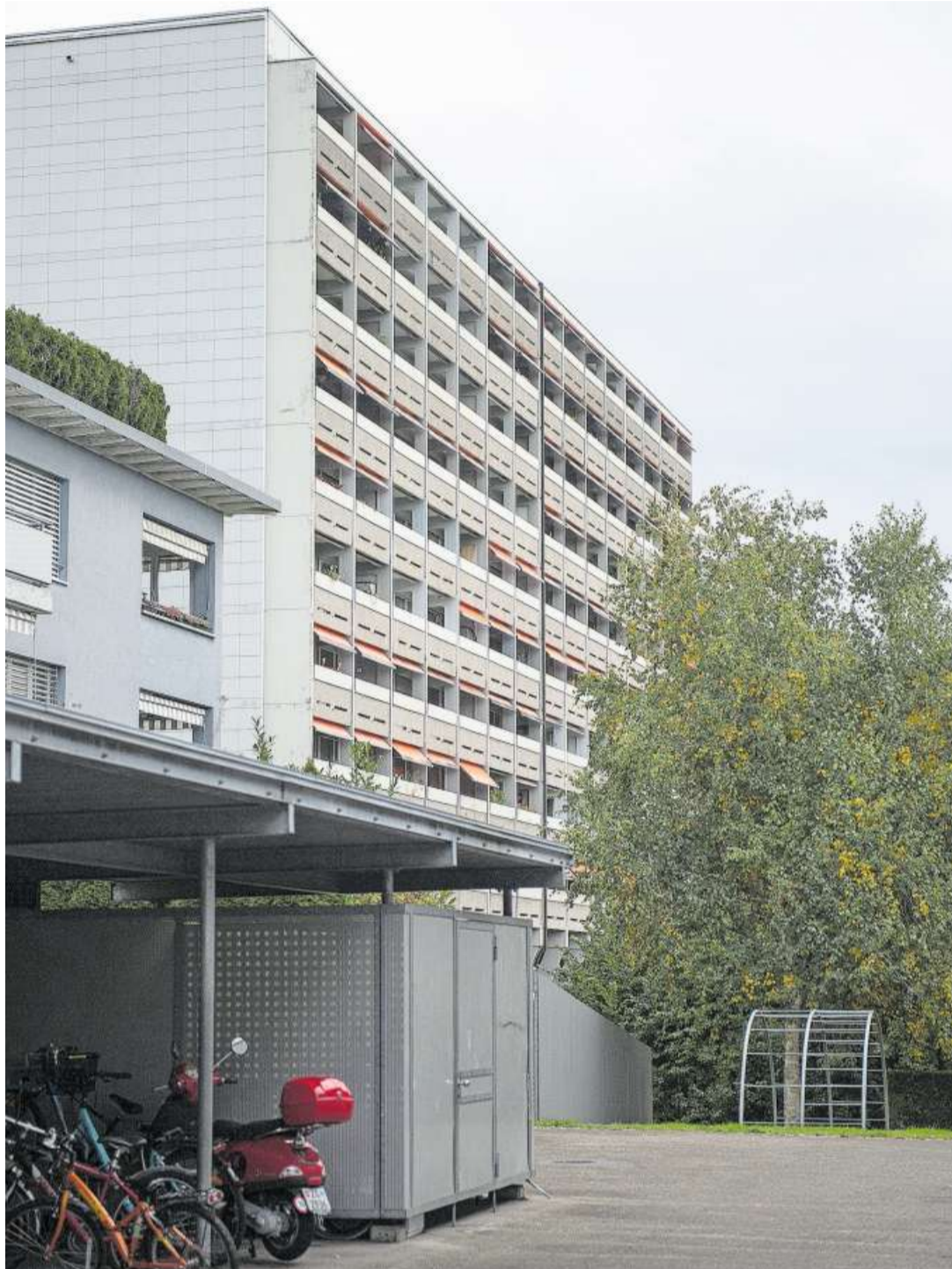
Die Scheibenhäuser in Inwil müssen abgerissen werden.
