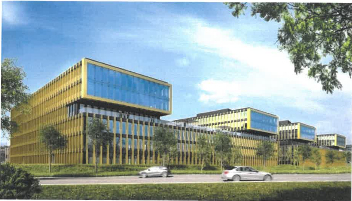
Der Quadrolith in Baar liegt unweit des geplanten Greenbuildings. (Bild: zvg)
